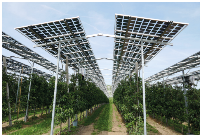
Abbildung 3: AgriPV Anlage mit semi-transparenten Almaden M50w-260 Wp Modulen in Kressbronn
