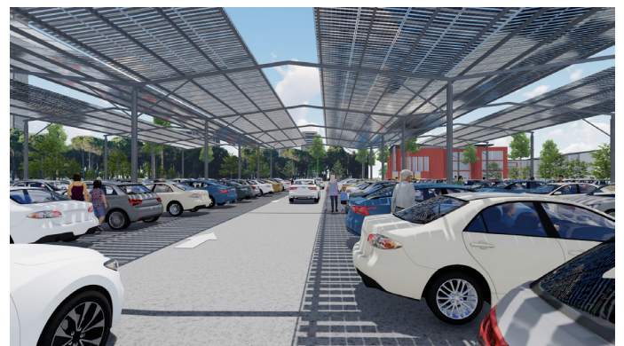
Abb1: Großparkplatz-Anlage mit viel Licht durch semi-transparente Doppelglas-Module.
